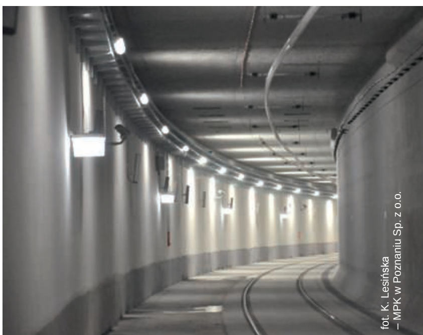
Fot. 6. Wnętrze tunelu tramwajowego. Widoczny m.in. system oświetleniowy zastosowany w tunelu do Zajezdni Franowo.
