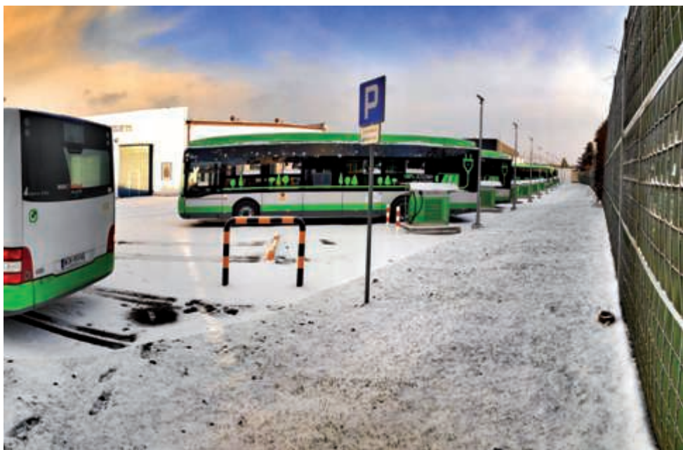
Fot. 1. Autobusy elektryczne zakupione przez Komunikację Miejską w Szczecinku są ładowane na zajezdni. System pozwala na jednoczesne ładowanie wszystkich 10 autobusów. Stacja zasilająca umożliwia dalszą rozbudowę systemu ładowania.
