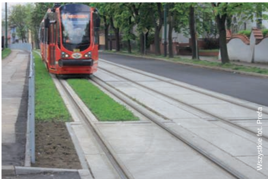
Fot. 1. W Sosnowcu, na około 200-metrowym odcinku ulicy Mariackiej, na części torowiska położonej bliżej chodnika, wykonawca zastosował system rowkowo-zalewowy RZC, co dało bardzo pozytywny efekt wizualny.
