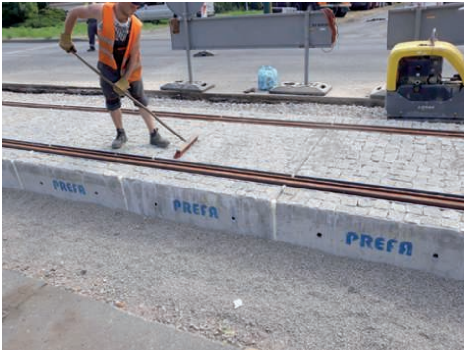
Fot. 3 . Prefabrykaty VRZB i zestaw żywic syntetycznych Premiks zastosowano przy okazji remontu torowiska w Będzinie, w ulicy Partyzantów.
