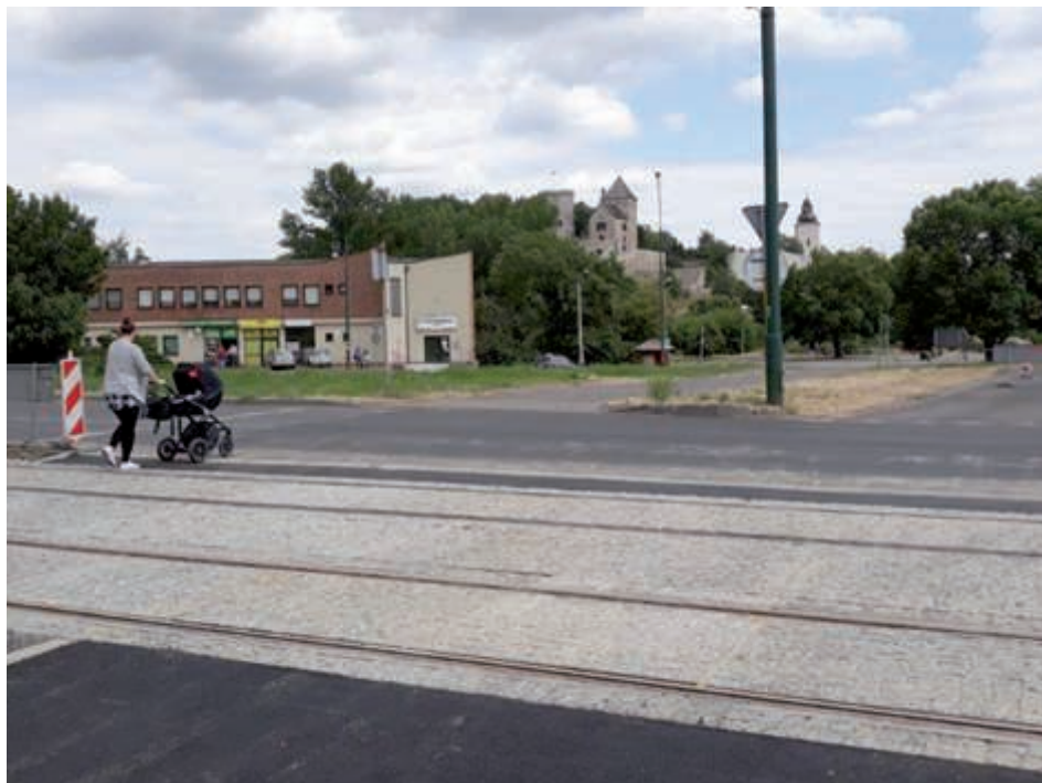
Fot. 4 . Torowisko w Będzinie po remoncie. W tle widoczny średniowieczny zamek rycerski zbudowany z naturalnego kamienia.
