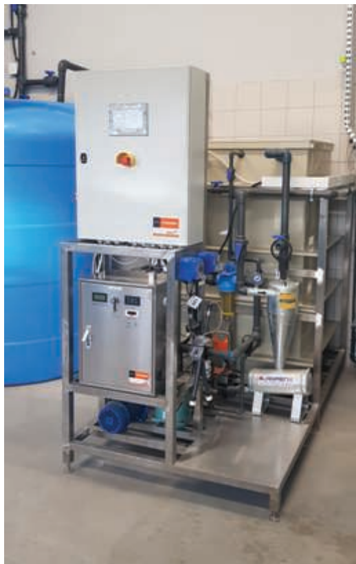
Fot. 9-10. Myjnia autobusowa w Opolu (fot. 9) i tramwajowa we Wrocławiu (fot. 10). Ozonowanie wody w układzie recyklingu. Proces oczyszczania wody zachodzi w tzw. ozonatorze.
