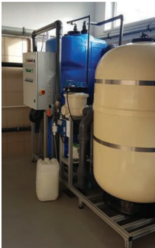
Fot. 9-10. Myjnia autobusowa w Opolu (fot. 9) i tramwajowa we Wrocławiu (fot. 10). Ozonowanie wody w układzie recyklingu. Proces oczyszczania wody zachodzi w tzw. ozonatorze.
