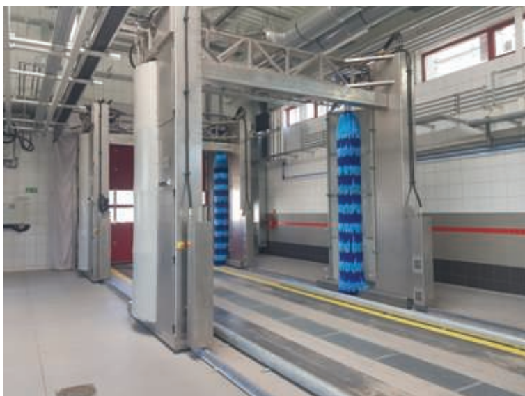
Fot. 6-7. Przykłady myjni portalowych - myjnia autobusowa w Opolu (fot.6) oraz myjnia tramwajowa we Wrocławiu (fot. 7). Portale poruszają się po szynach wzdłuż stojącego taboru, a trakcja na czas mycia jest automatycznie wyłączana. Takie myjnie charakteryzują się mniejszą przepustowością. ▲ ►
