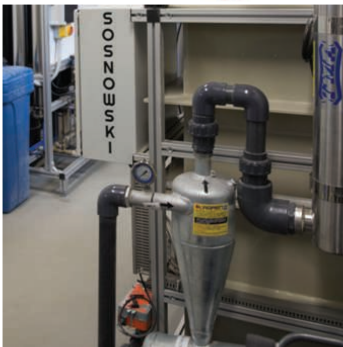
Fot. 8. Hydrocyklon w myjni tramwajów w Gorzowie Wlkp.
