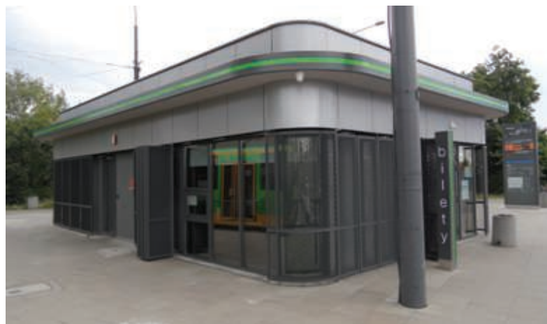
Fot. 2. Realizacja nowego PNR „Dębiec”.
