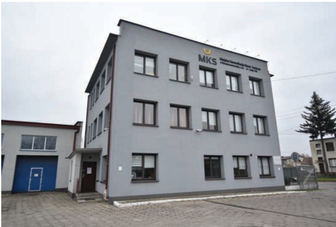
Fot. 1. Ważnym elementem remontu zaplecza zajezdniowego w 2016 roku było przeprowadzenie termoizolacji budynków.
