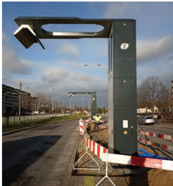
Fot. 5. Kraniec Nowodwory, w budowie 2 ładowarki pantografowe.
