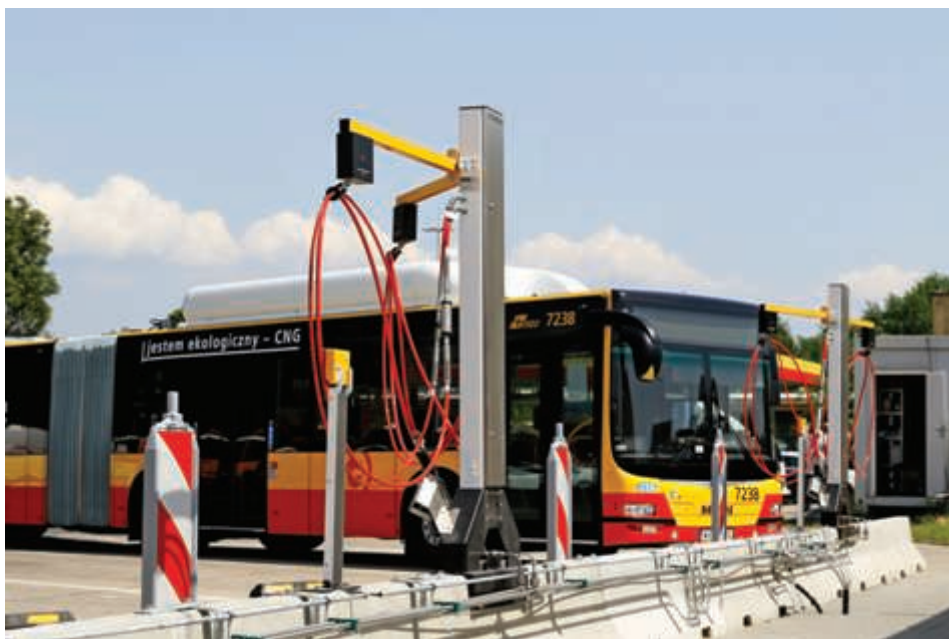
Fot. 2. Ważne jest, aby obecne zmiany legislacyjne nie przekreśliły ponoszonych w ostatnich latach wielomilionowych inwestycji w infrastrukturę gazową. Na zdjęciu nowo wybudowane stanowiska tankowania autobusów CNG w zajezdni MZA Warszawa, przy ul. Kleszczowej.
