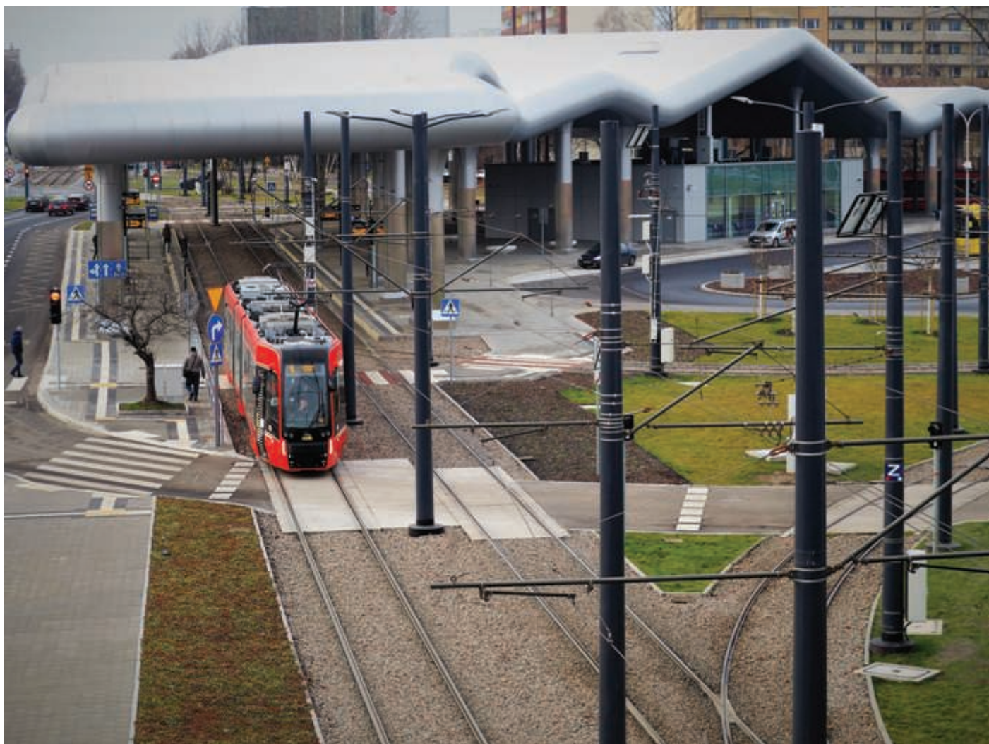
Fot. 7. Nowy węzeł komunikacyjny Katowice Zawodzie doskonale wpisuje się w obecne trendy integracji różnych rodzajów mobilności, co podnosi atrakcyjność transportu publicznego. W obrębie węzła znajdują się przystanki tramwajowe, autobusowe oraz parking dla samochodów osobowych i stojaki na rowery miejskie.
