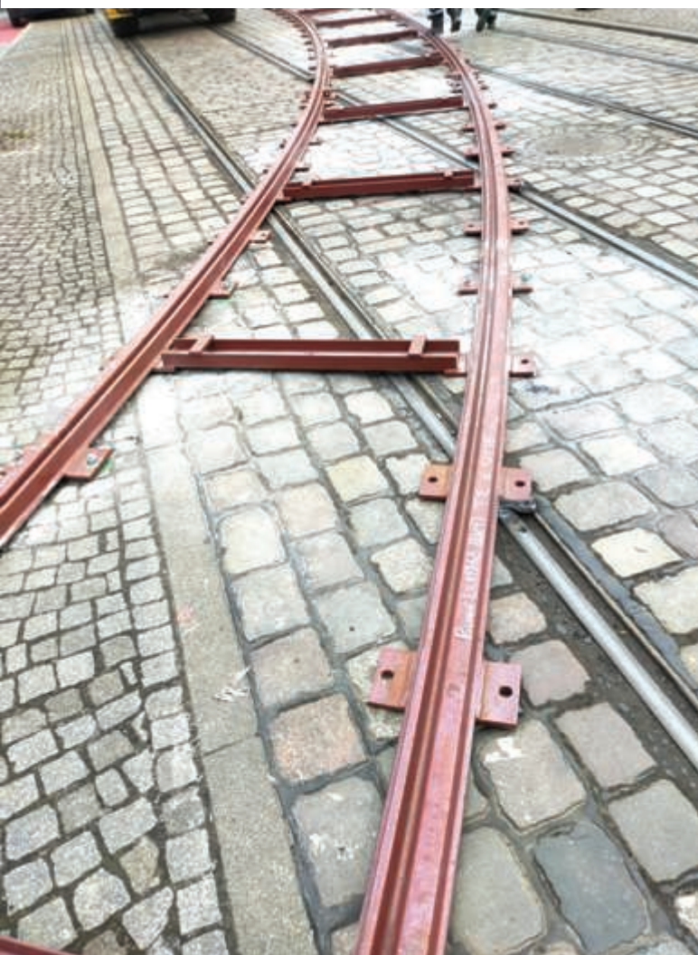
Fot. 1. Tor nakładkowy ułożono na dotychczasowym torowisku.
