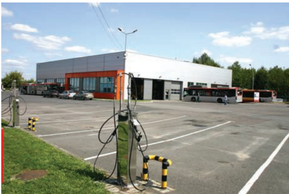
Fot. 3. Rzeszów – zajezdnia MPK, hala dla autobusów CNG i linia wolnego tankowania. Przewoźnik postawił na autobusy ekologiczne napędzane sprężonym gazem ziemnym.
