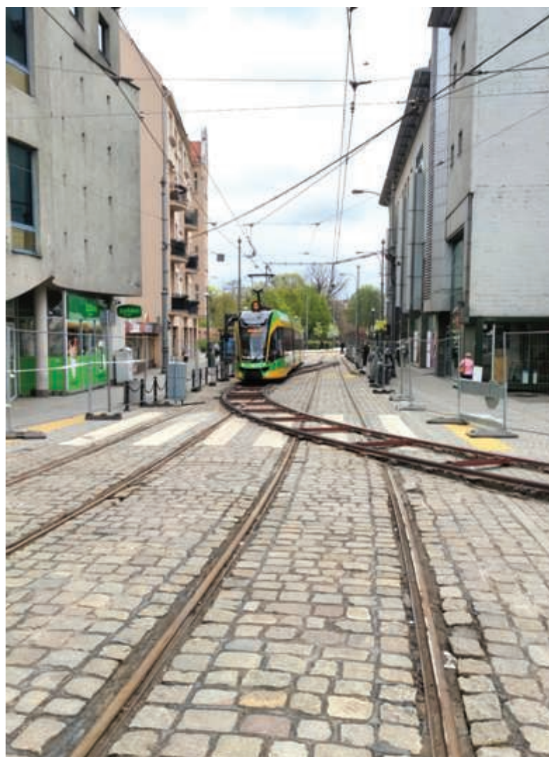
Fot. 1. Tor nakładkowy ułożono na dotychczasowym torowisku.
